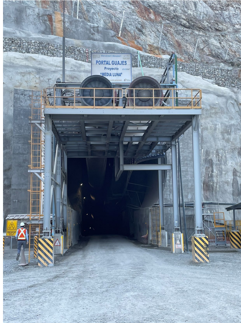
Guajes Tunnel Portal
