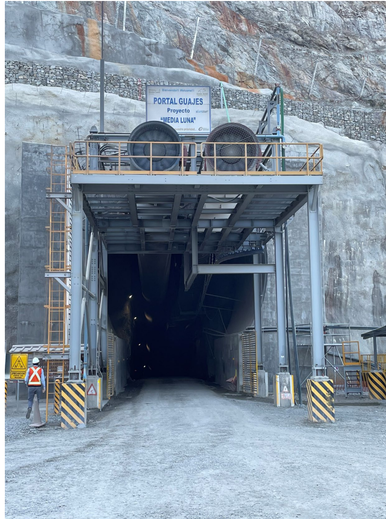
Guajes Tunnel Portal
